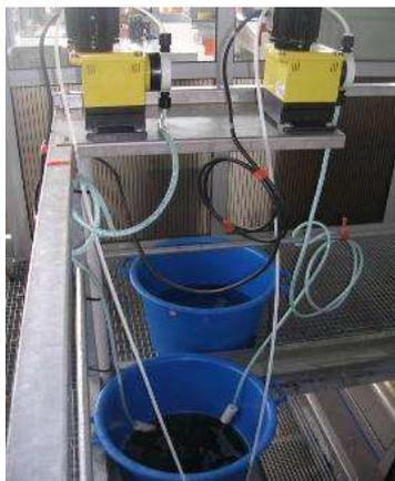
Photo 1 : Système de pompes d'injection (UVICA)
